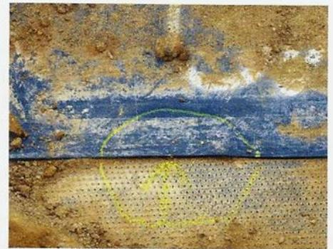
Figura 8 – Falha identificada na solda da emenda entre as geomembranas
